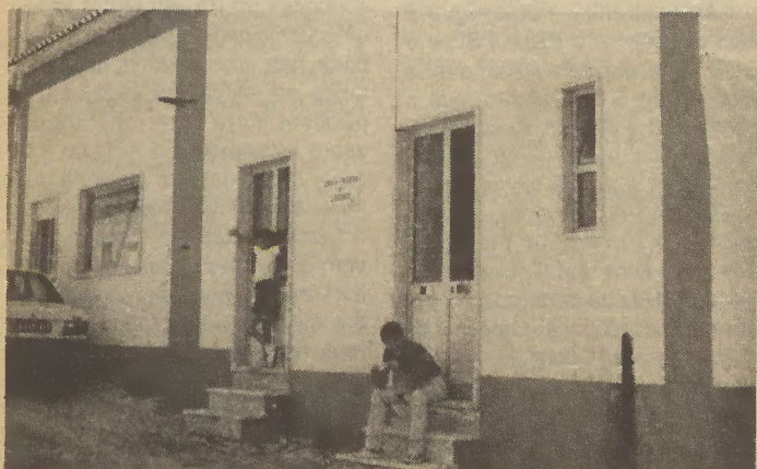
Perspectiva da nova sede da Junta de Freguesia de S. Facundo, na fase de acabamento e a dois meses da inauguração
