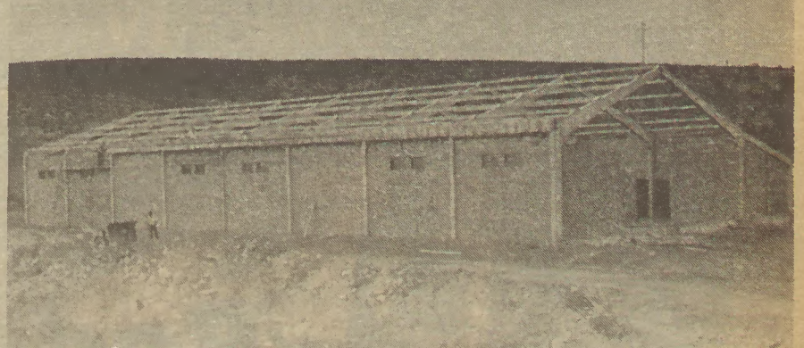
O novo armazém da Câmara (na foto) vai libertar as antigas instalações para o Mercado de Vila do Bispo
