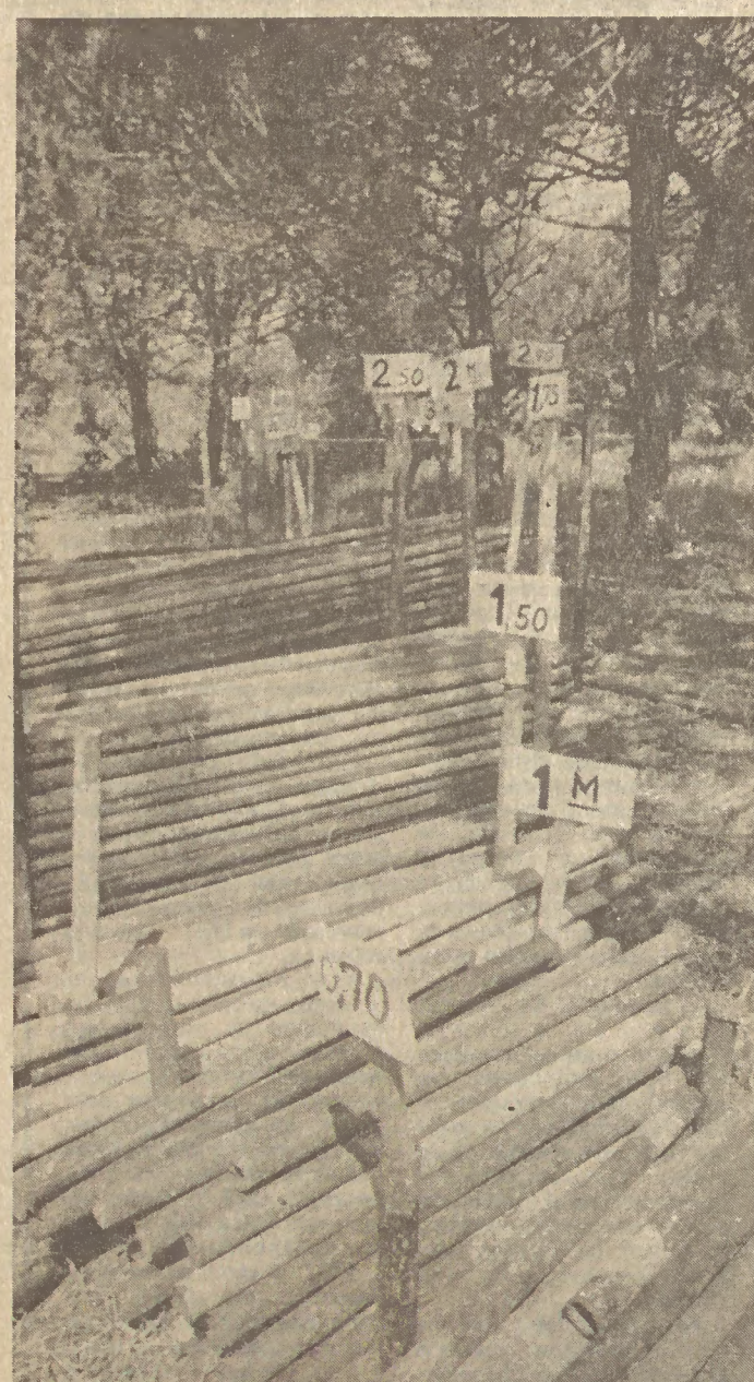
No domingo passado registou-se já um bom avanço. Abriram-se valas para as canalizações, ergueram-se as estruturas de tubo dos pavilhões centrais, avançou-se, enfim, num trabalho que se prolongará até à Festa para que ela atinja e ultrapasse o êxito dos anos anteriores, como querem (e conseguirão) os trabalhadores comunistas e as massas trabalhadoras com o esforço e a vontade que fez no ano passado do Casalinho da Ajuda um imenso e agradável local de festa.
