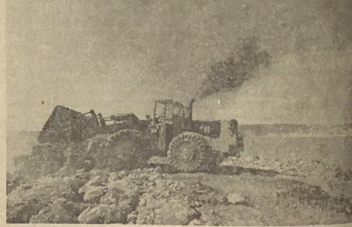
Obras no porto de Abrigo
