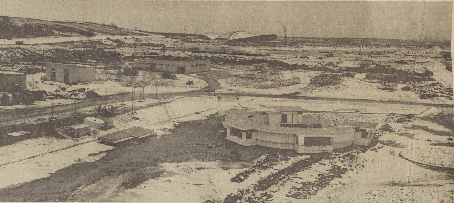
Um aspecto dos trabalhos olímpicos na zona de Khrushchevo, em Moscovo: ao fundo, o velódromo coberto e, no canto superior direito, parte da nova pista de ciclismo
