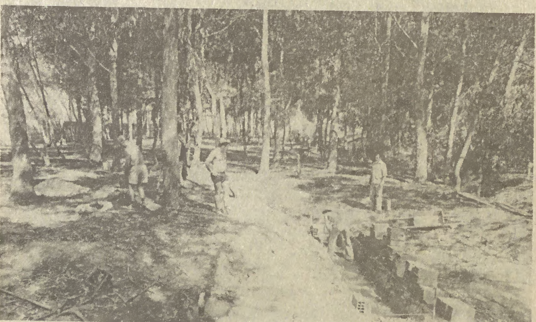
Na vasta área dedicada ao parque de campismo, nada foi esquecido. Podemos ver na foto os trabalhos de instalação de sanitários e de duchos. A cada um a sua tarefa. E a orientação dos trabalhos no parque de campismo cabe a um camarada que é campista experientado
