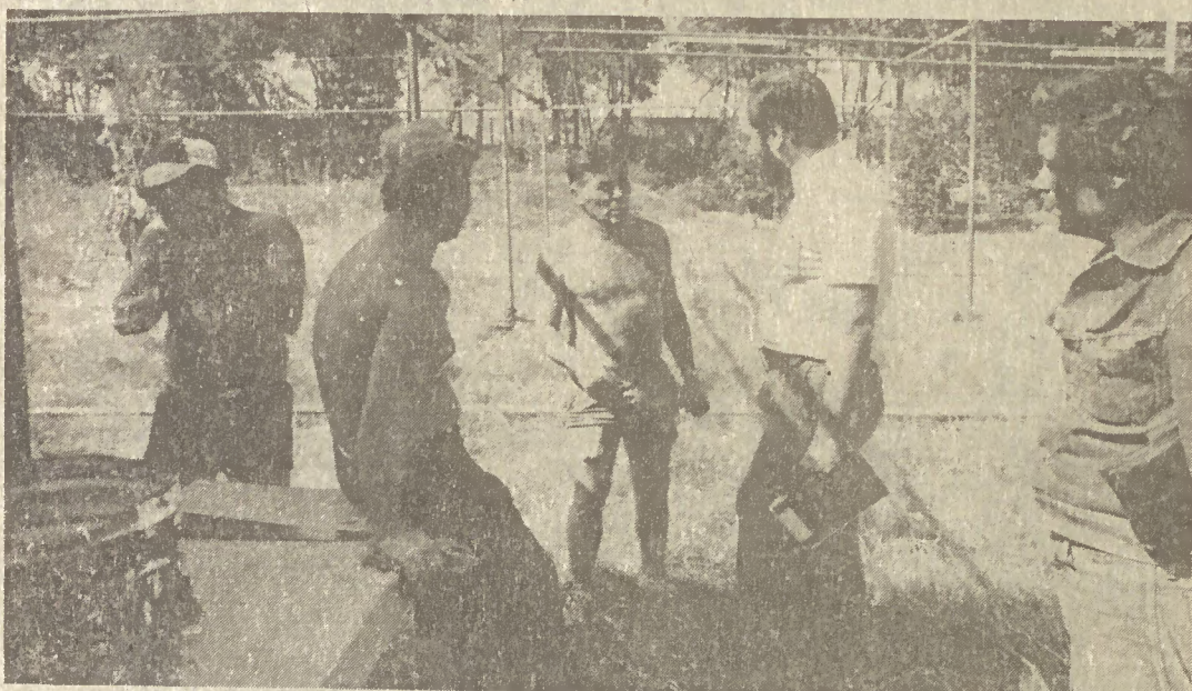
«Só páro quando tudo estiver pronto», disse-nos o camarada responsável pela montagem das estruturas de tubo. Um entre os muitos que estão dispostos a terminar os trabalhos nos prazos previstos e que, com entusiasmo, se dedicam às tarefas da instalação
