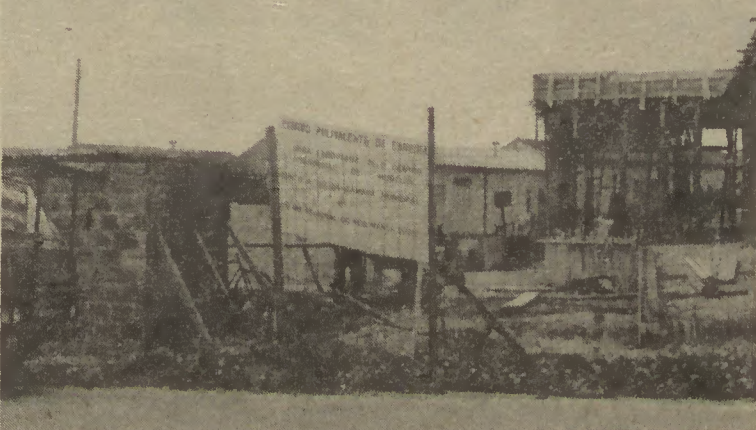
Centro Polivalente da Caneira; mais uma obra prometida em 1985 pelo PS/PSD e que continua à espera...
