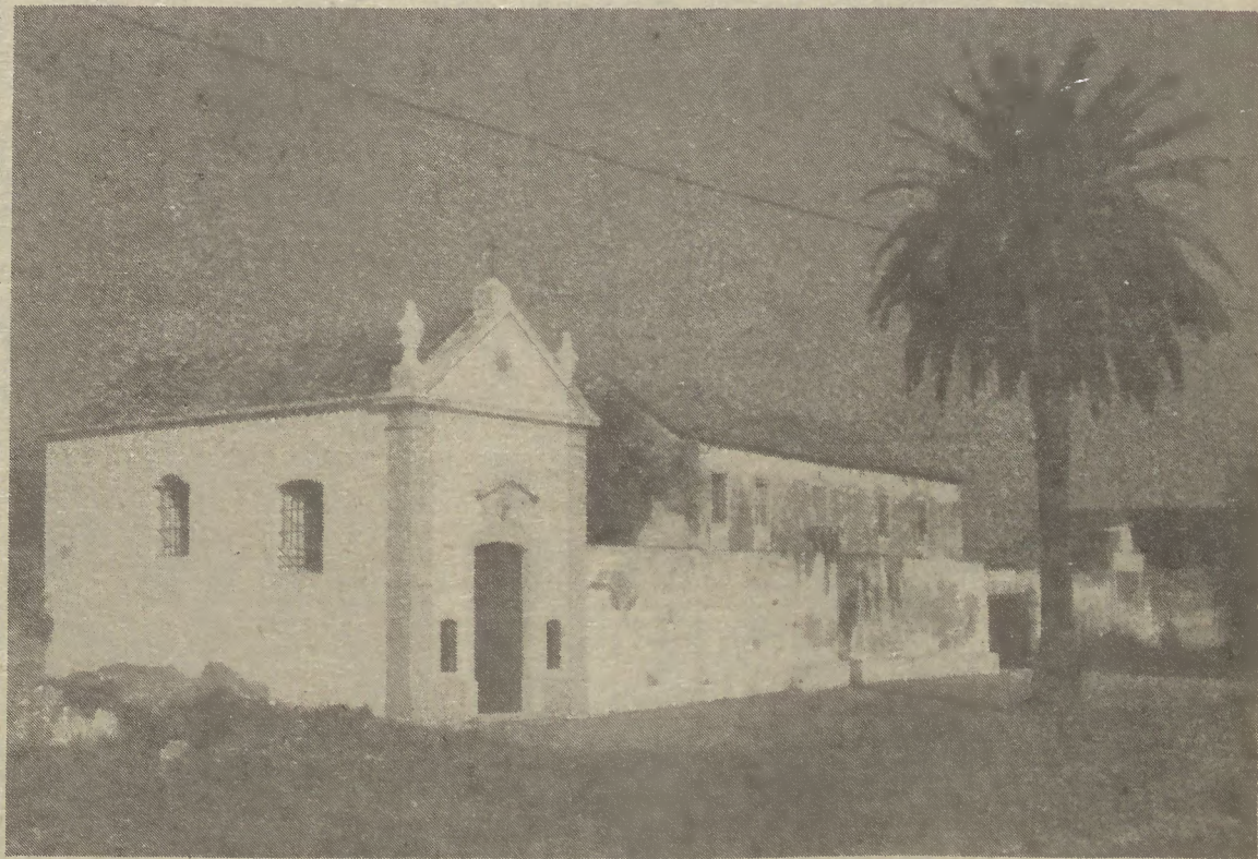
É aqui que vai ser instalado o Centro de Arte e Cultura do Montijo; o projecto, aprovado no último mandato da CDU, teve de esperar estes quatro últimos anos pela concretização, dado que o executivo PS/PSD nem sequer pagou aos arquitectos que executaram o projecto... Agora continua a ser uma das prioridades da CDU
