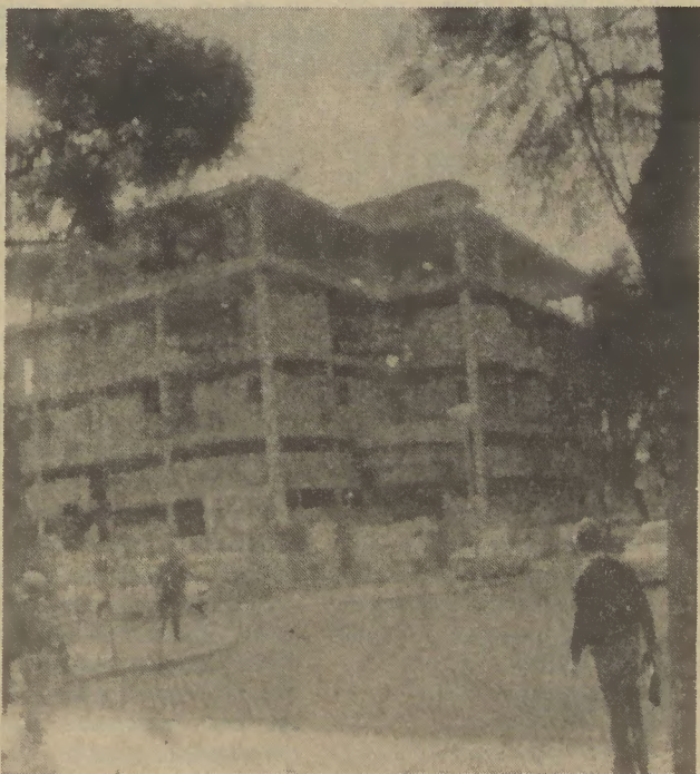
É aqui, na Avenida 5 de Outubro, o novo CT da DORS. O seu aspecto geral já não será muito diferente. Apenas mais belo
