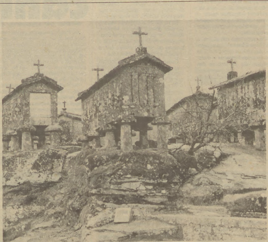
Os espigueiros, tal como a eira onde se encontram, são propriedade comunitária dos soajeiros, e destinam-se à armazenagem e conservação das espigas, quase exclusivamente de milho grosseiro. As suas paredes apresentam fendas verticais para arejamento e assentam numa base de pés simples, rematada por cornijas ou capitéis salientes, de forma a impedir o acesso dos roedores. No Soajo os espigueiros são de pedra e na sua grande maioria remontam aos meados do século XIX, embora haja exemplares datáveis da 2.ª metade do século XVII.
