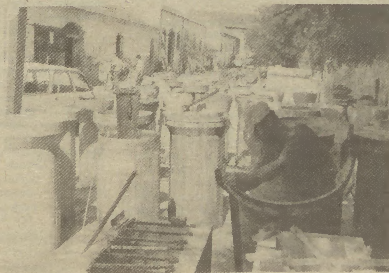
A administração directa é a espinha dorsal da actividade do município (na foto, pormenor da feitura de manilhas nos estaleiros da Câmara)
