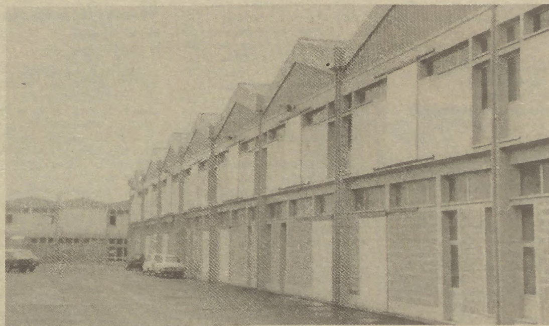
Peniche: é quase inacreditável que a velha lota continue a operar; para além da falta de condições para os seus trabalhadores, é a própria segurança do edifício que está em causa; entretanto, o novo conjunto construído (foto) permanece quase paralisado sem que ninguém saiba ou queira informar a população e os pescadores de Peniche sobre o arranque a sério da sua utilização...
