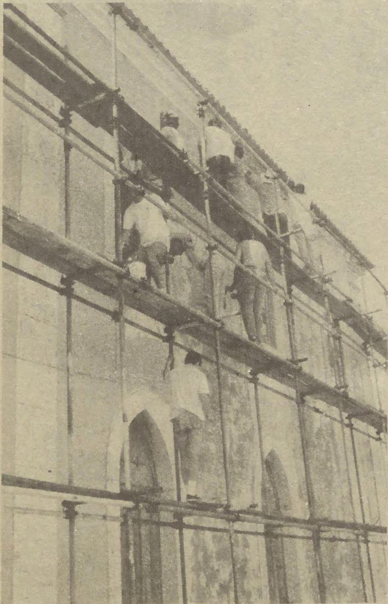
O andaime para a pintura desta fachada do solar tinha sido montado apenas no dia anterior. Por este andar em breve pode ir servir outras paredes!
