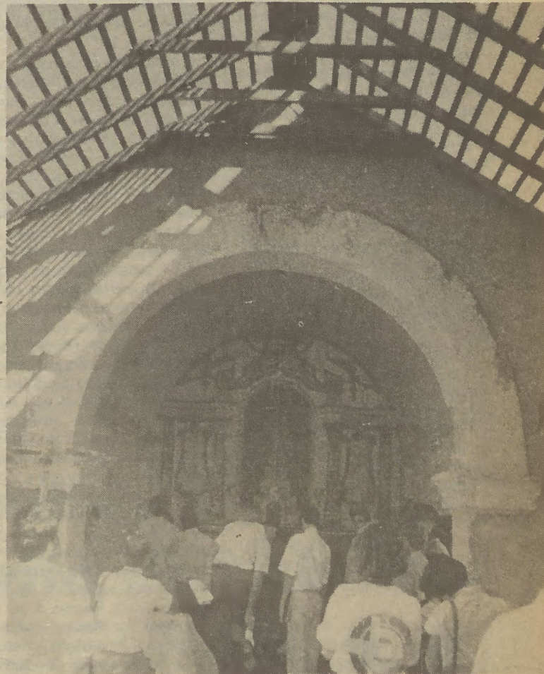
«A defesa do património enquanto fonte de valorização e de projecção para o desenvolvimento» é uma preocupação da Câmara Municipal de Santiago do Cacém. (Na foto, trabalho de restauro da Igreja de São Bartolomeu, na freguesia de São Bartolomeu. Um monumento construído em 1500)
