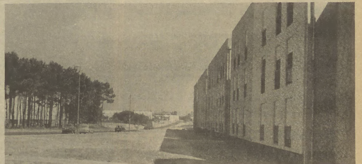
O Centro Urbano de Santo André nasceu torto. Só há pouco tempo, e por iniciativa da Câmara, a população começou a ter distribuição de correio ao domicílio. A degradação dos edifícios é evidente. No entanto, o problema mais premente é o da escola preparatória. Esta escola está instalada num edifício programado para o ensino primário. São 530 alunos a trabalhar onde deveriam estar apenas 250 e de um outro grau de ensino. Uma situação que levou já à total rotura desta escola, das escolas primárias e também da secundária. Um problema que urge resolver. Também o centro de saúde tem que se lhe diga. Dimensionado para ter consultas de especialidade, funciona apenas com quatro clínicos gerais (para uma população de 10 500 pessoas) e falta-lhe material básico. Faltam-lhe pensos rápidos!
